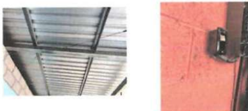
FOTO 5: REPARACIÓN DE SISTEMA ELÉCTRICO Reparación de instalaciones eléctricas, cableado distribuido a tomacorrientes y circuitos de iluminación
