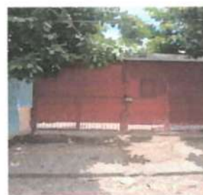
FOTO 7: MANTENIMIENTO A PORTONES Mantenimiento a portón de ingreso, material: metálico, incluye: bisagras y sistemas de cierre.
